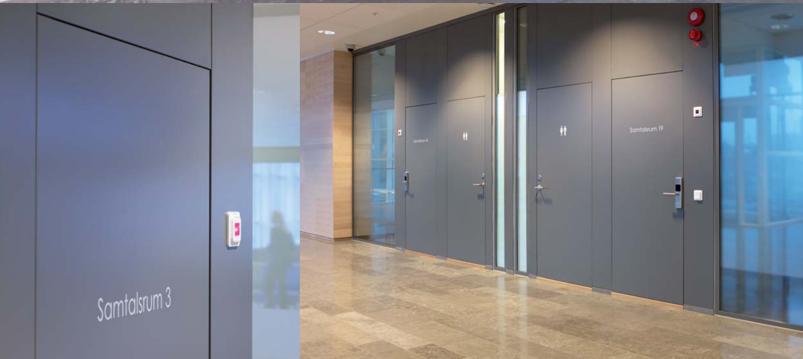
Södertörns Tingsrätt: Här är de inåtgående trädörrarna nästan osynliga – täckmålade i samma färg som väggpanelen. Inga synliga gångjärn och dold karm.
